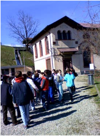
La Centrale Idroelettrica della Società Enel
